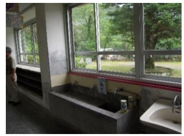
図 2.3.6 川上小学校内部
